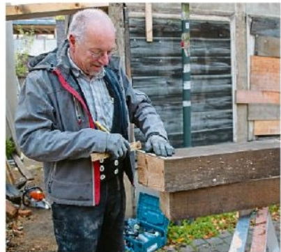
Eichenbalken werden dort neu eingesetzt, wo die Ursbstanz nicht mehr zu retten ist. Die Zimmerer Werner Koppenstein übernimmt die Sicherungsarbeiten am Objekt.
